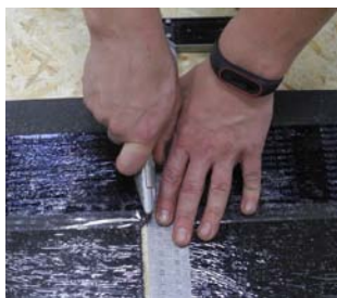
Рис. 86. Деление плитки на лепестки
