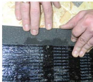
Рис. 85. Насечка для облегчения монтажа
