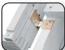
Монтаж на стропилах
